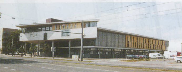
Ansicht zur Walther-Rathenau-Straße
